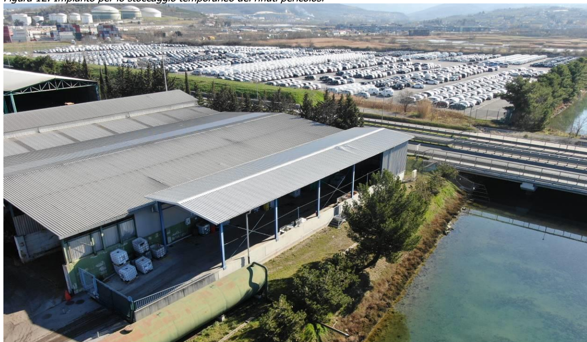
Figura 12: Impianto per lo stoccaggio temporaneo dei rifiuti pericolosi
