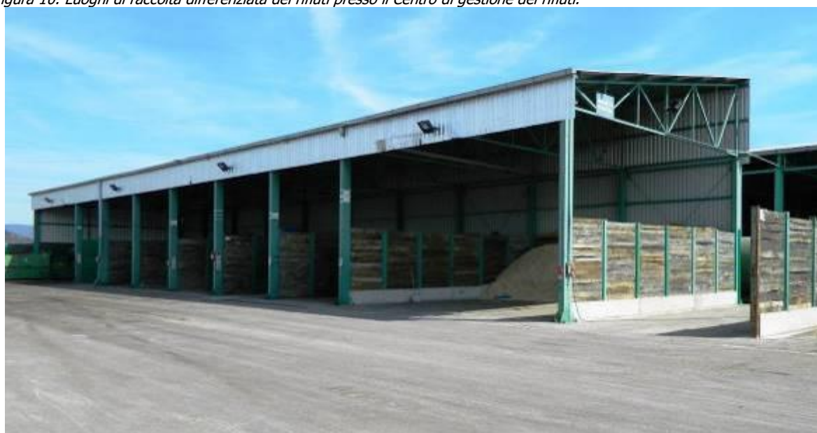
Figura 10: Luoghi di raccolta differenziata dei rifiuti presso il Centro di gestione dei rifiuti.
