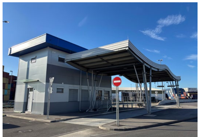
Pregledno mesto je opremljeno z rampo in nadstrešnico, kar omogoča boljše delovne pogoje.
