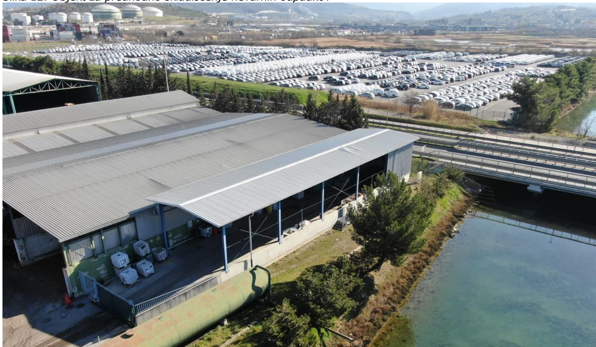
Slika 12: Objekt za predhodno skladiščenje nevarnih odpadkov
