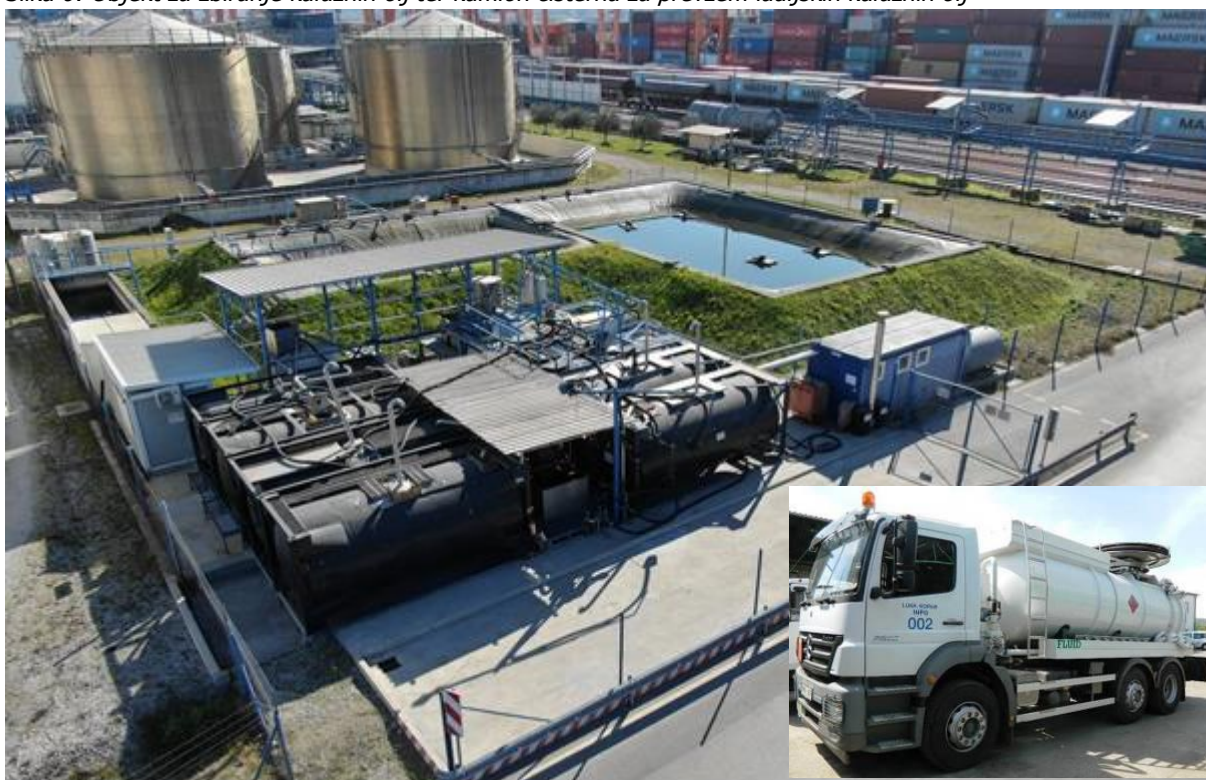
Slika 6: Objekt za zbiranje kalužnih olj ter kamion cisterna za prevzem ladijskih kalužnih olj
