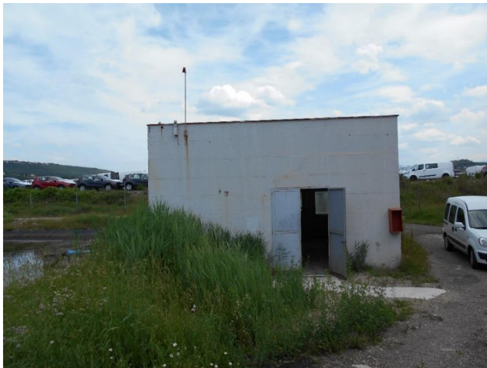
Slika 1: Objekt požarno-tehnološkega črpališča EET
